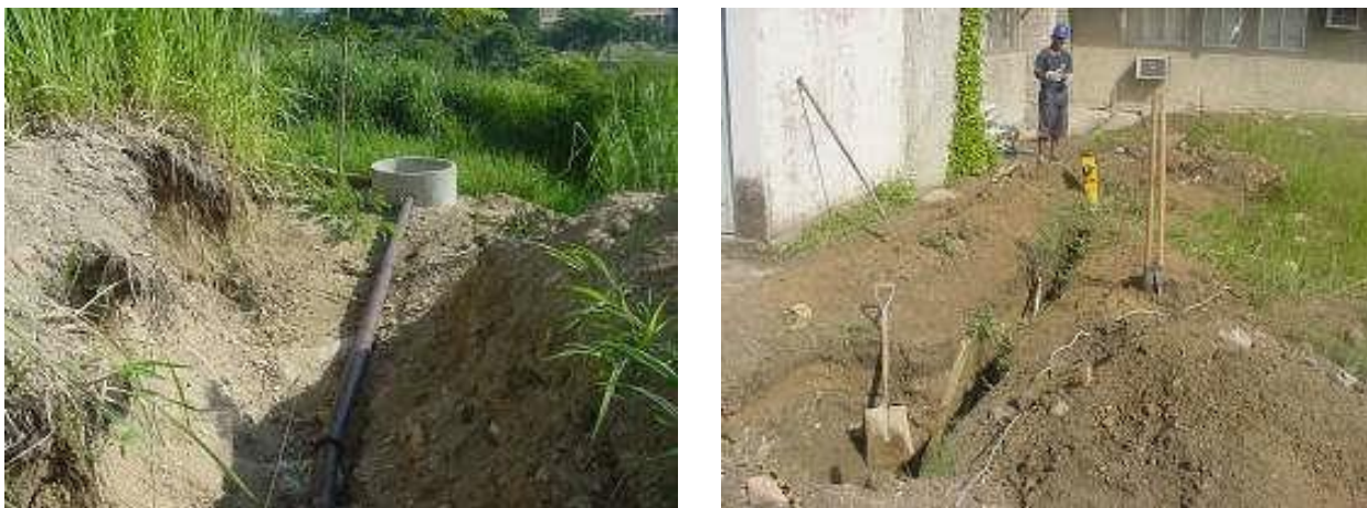
Fotografia nº 55 - Construção dos esgotos radioativos e químicos de um dos laboratórios do complexo
