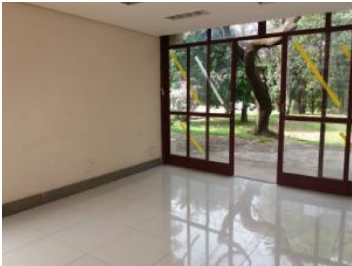
Fotografia nº 11 - Aprimoramento da iluminação natural do laboratório.
