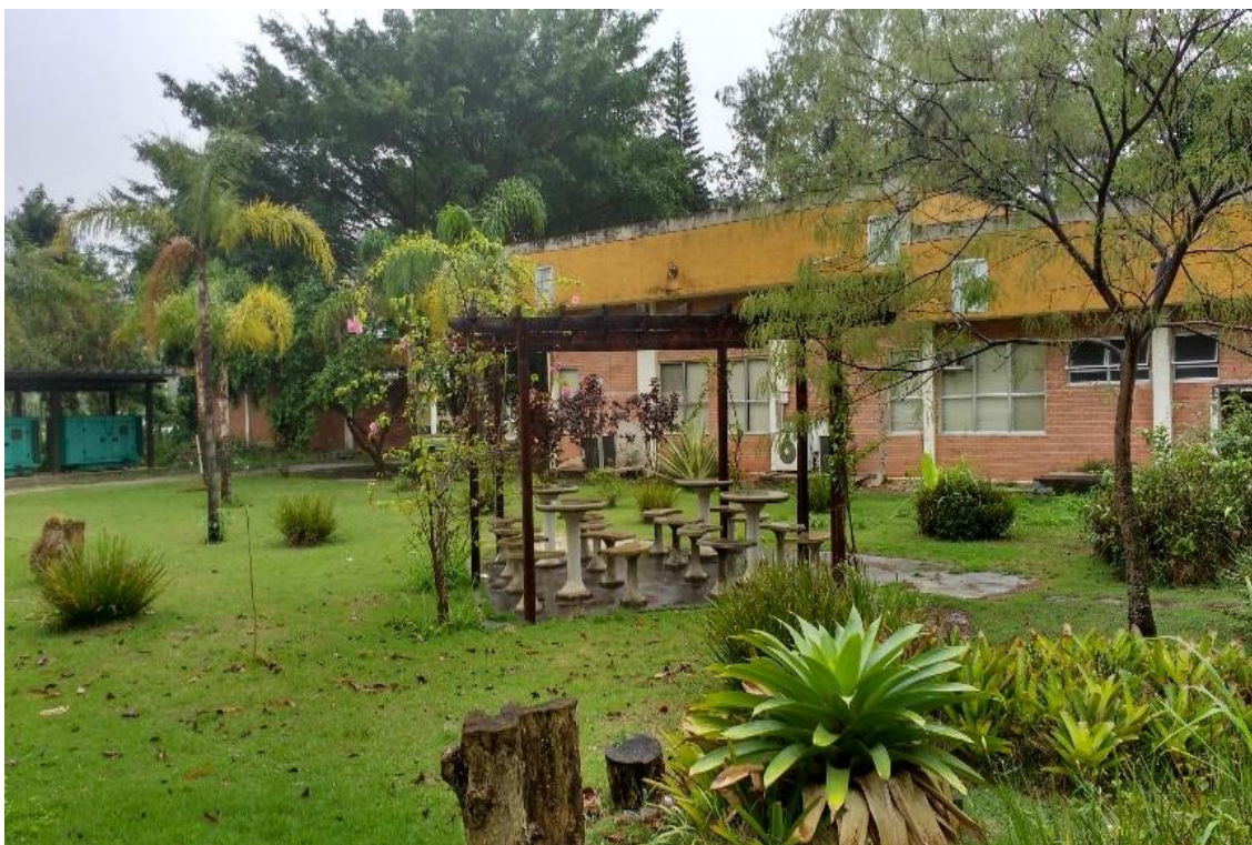
Fotografia nº 54 - Resultados da conservação das áreas externas das edificações.
