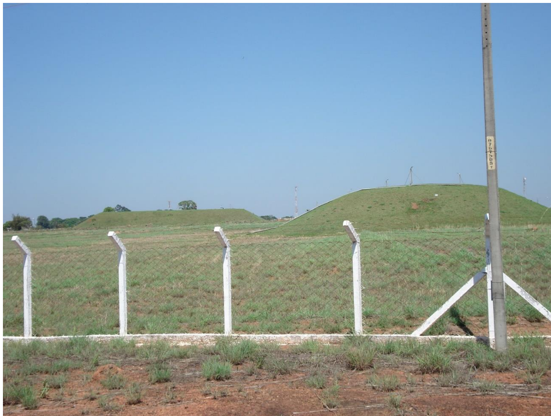
Fotografia nº 25 - Edificação dos repositórios de rejeitos.
