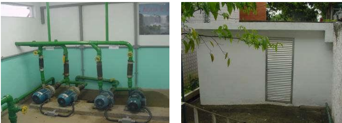
Fotografia nº 59 - Resultado da reforma nas instalações da casa de bombas
