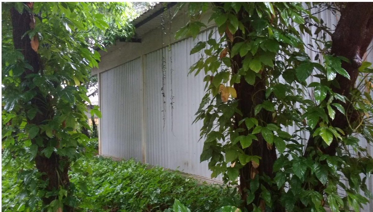
Fotografia n° 38 - Paredes com isolamento de poliuretano – visão externa
