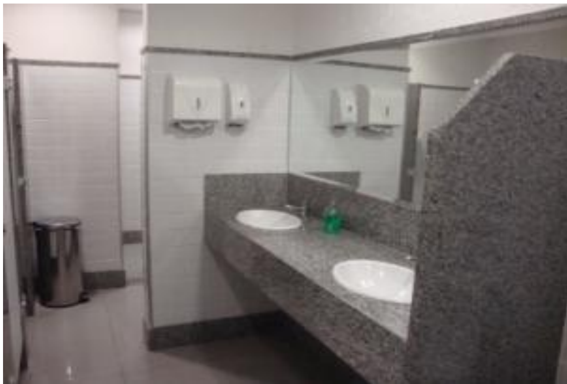
Fotografia n° 12 - Banheiro de acesso reformado com materiais de maior tempo de vida útil.
