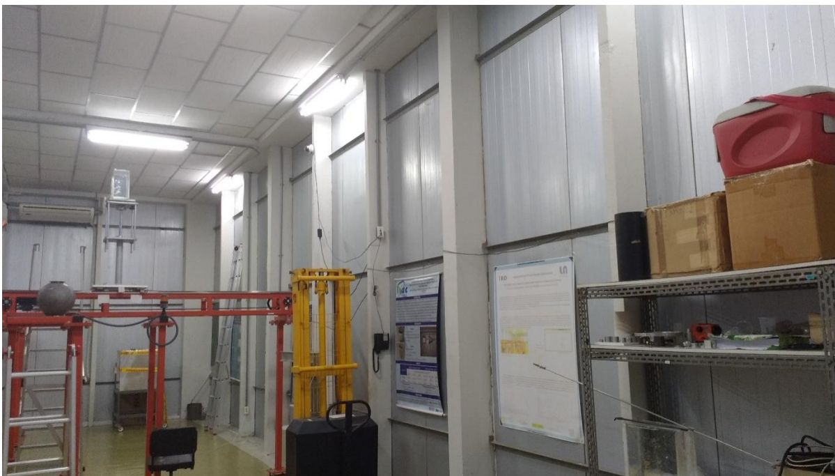
Fotografia nº 39 - Paredes com isolamento de poliuretano – visão interna
