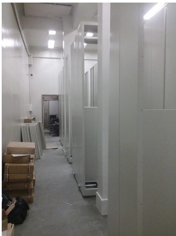
Fotografia n° 20 - Reforma na dependência 2 da edificação 1.
