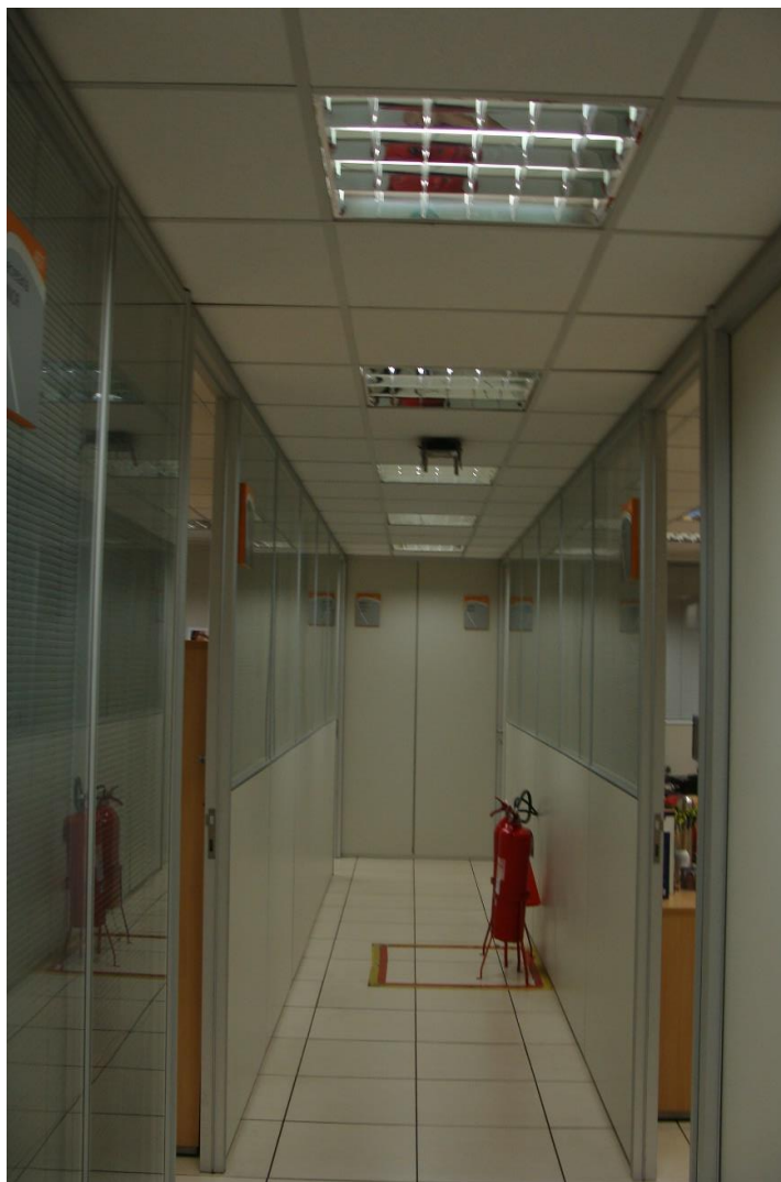
Fotografia n° 23 - Lâmpadas fluorescentes em luminária com refletor
