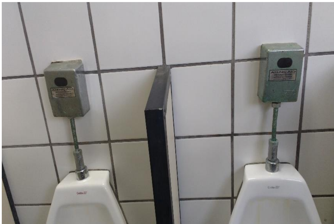
Fotografia nº 44 - Sensores de presença dos mictórios.
