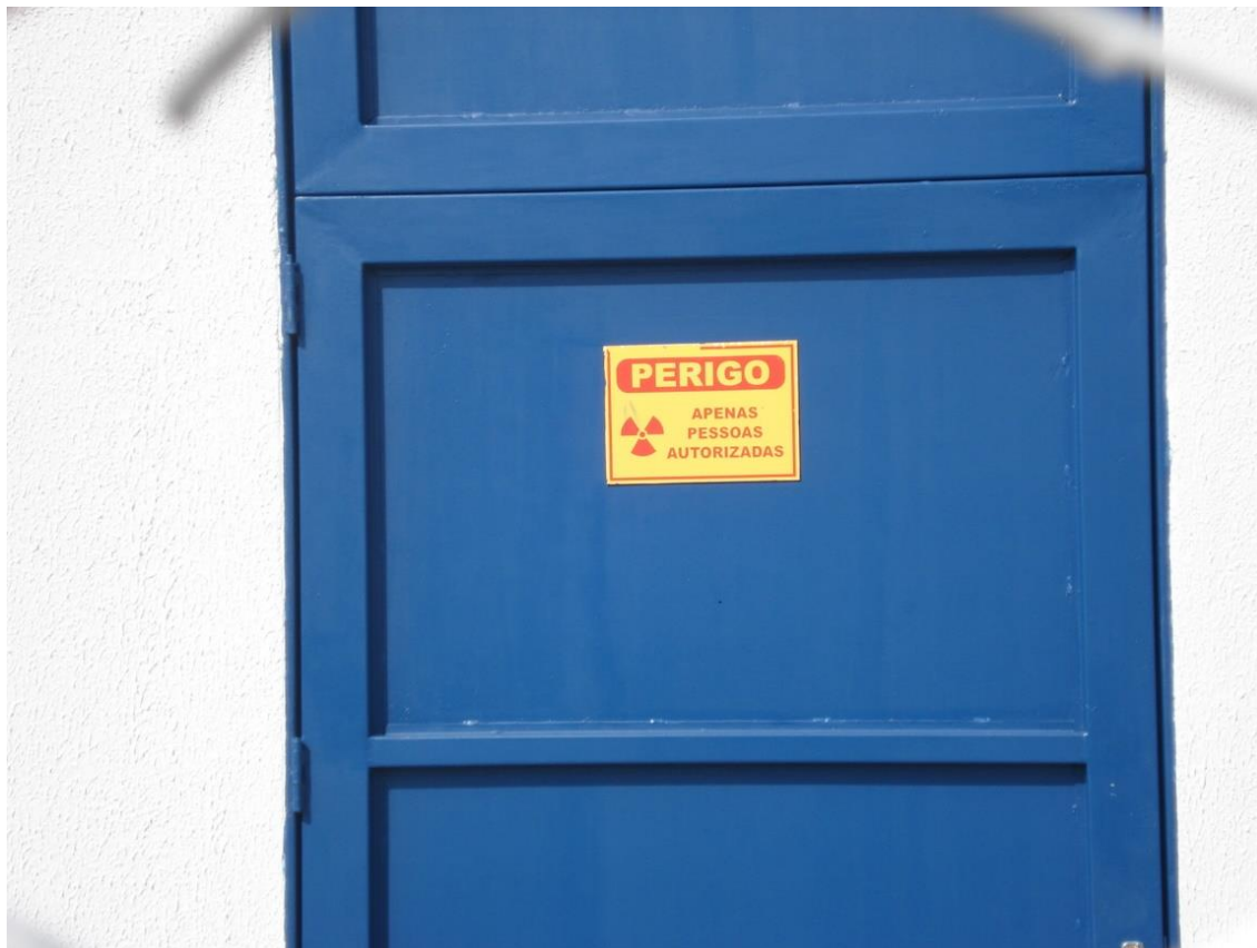
Fotografia nº 28 - Acesso controlado aos materiais em uso na edificação.
