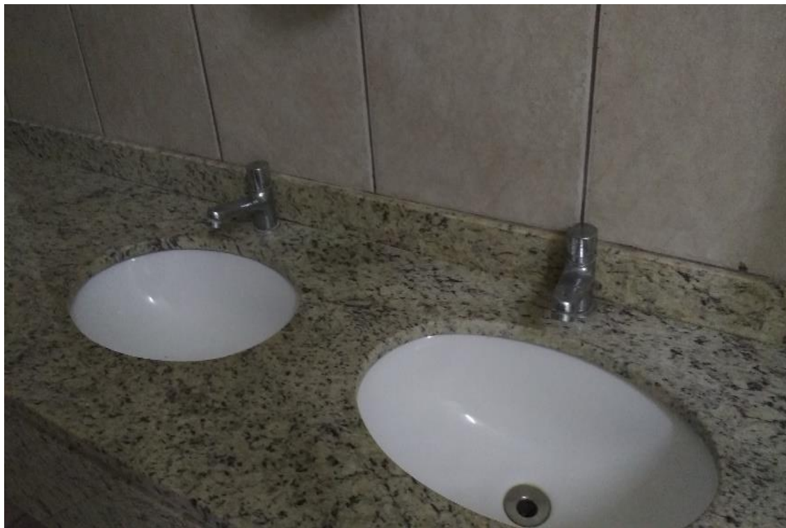
Fotografia nº 41 - Torneiras tradicionais por outras de baixo fluxo com temporizadores
