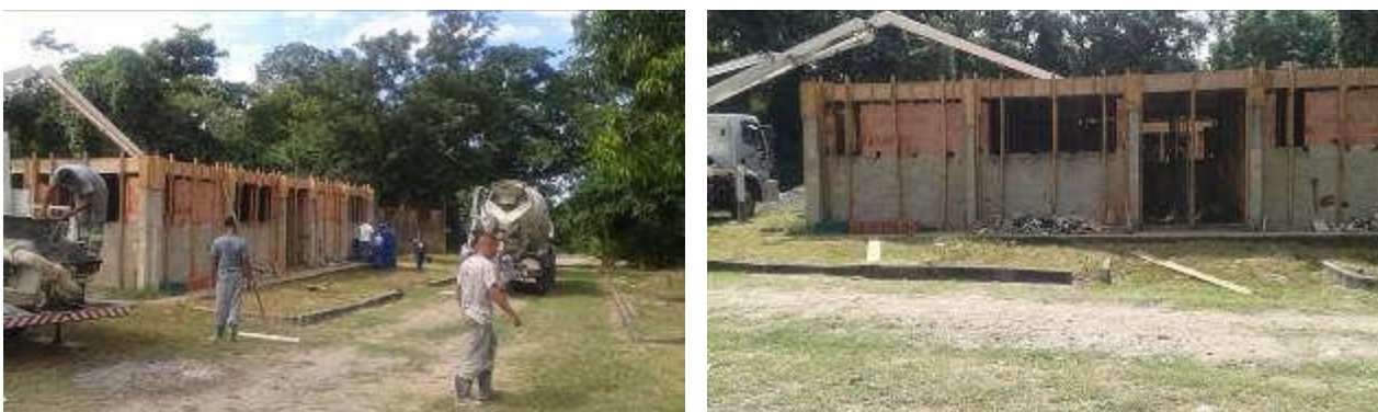
Fotografia nº 66 - Construção do prédio para atender ao pessoal terceirizado da organização.
