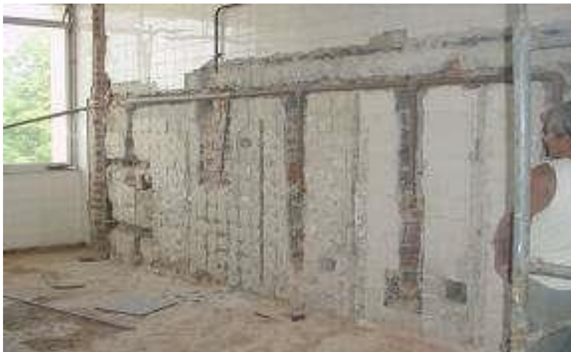
Fotografia n° 56 - Reforma dos sanitários de edificação do complexo de prédios.
