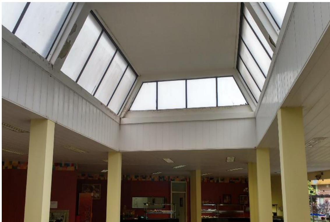
Fotografia n° 48 - Aperfeiçoamento da iluminação natural dos espaços – sala 1.
