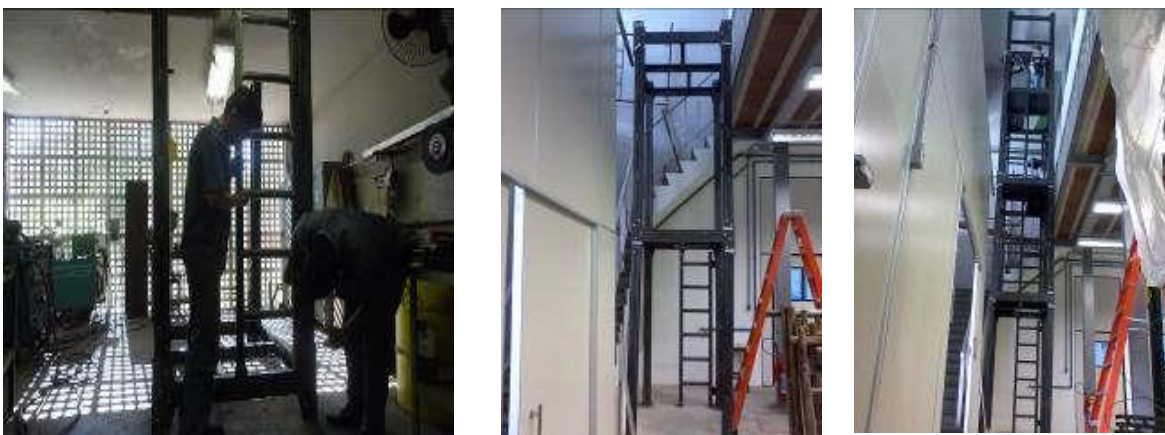
Fotografia nº 61 - Fabricação e montagem de estrutura de apoio a um experimento de escoamento.
