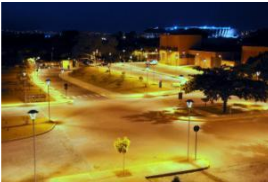
Fotografia n° 06 - Nova iluminação externa com lâmpadas de potência e consumo reduzido.
