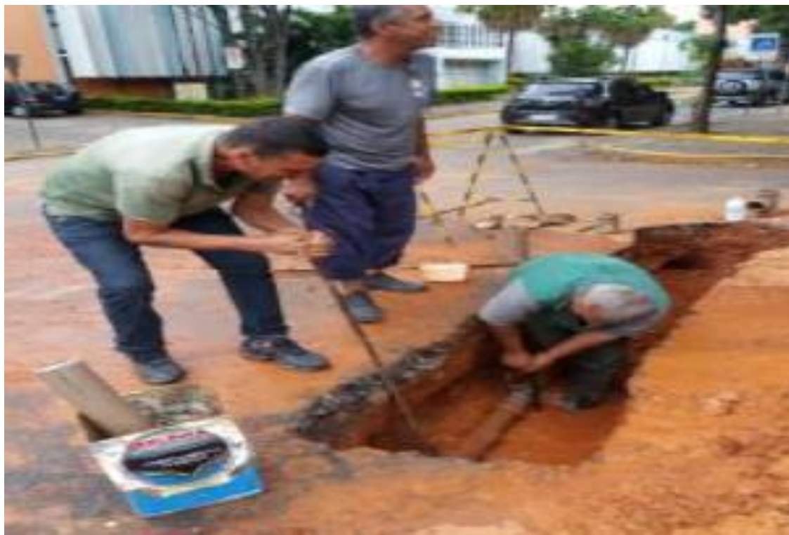
Fotografia n° 05 - Obra de recuperação do vazamento da rede de distribuição – tubulação 3
