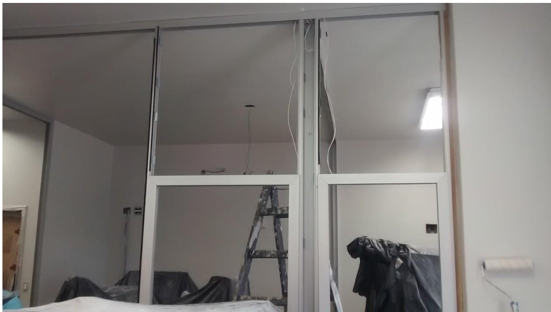
Fotografia n°19 - Reforma na dependência 1 da edificação 1.
