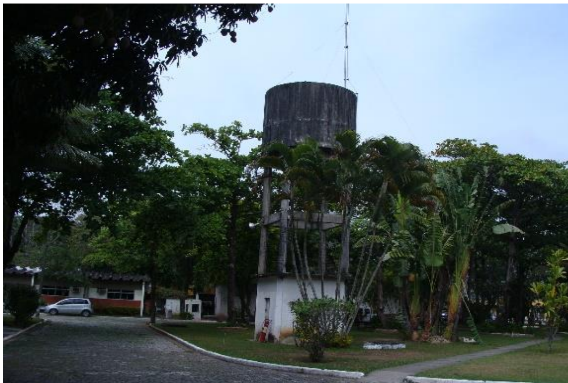
Fotografia nº 42 - Caixa de água: representação de antiguidade do sistema hidráulico.
