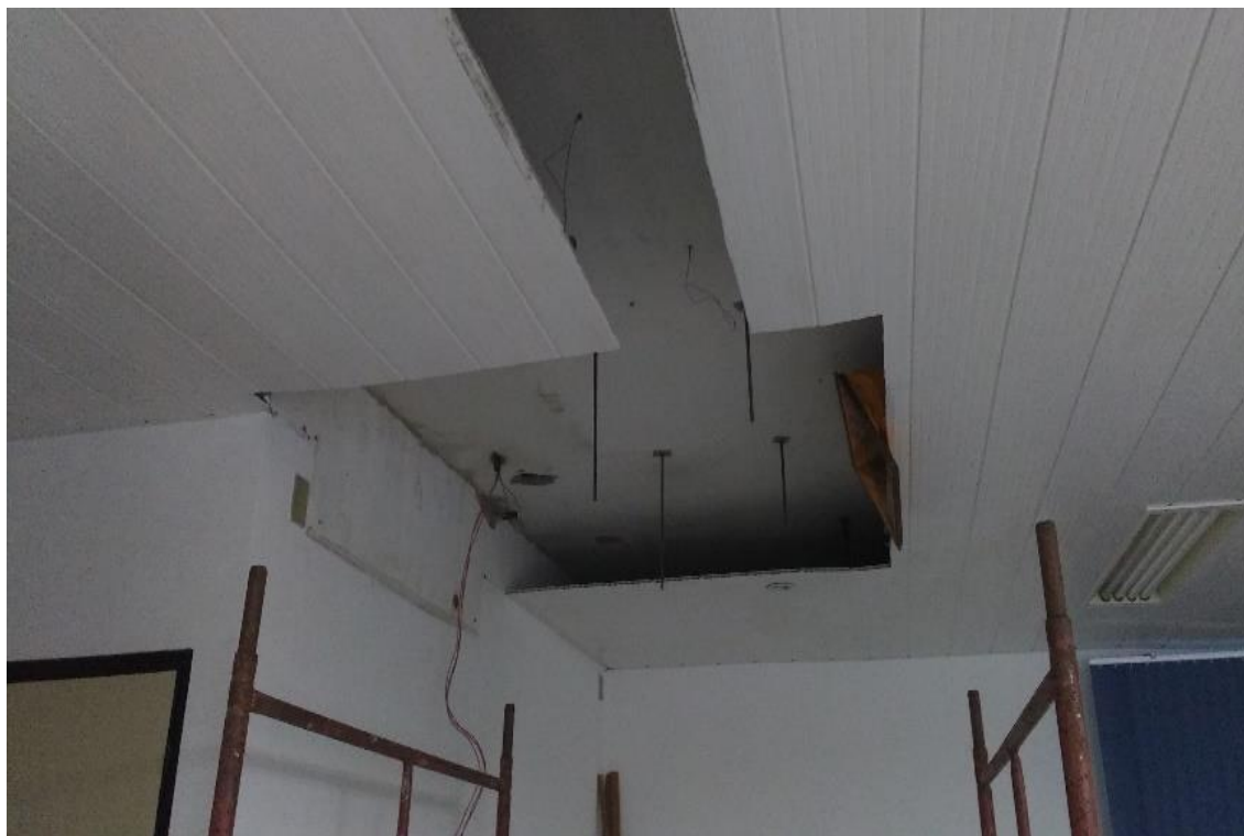
Fotografia nº 46 - Retrofit dos equipamentos de refrigeração
