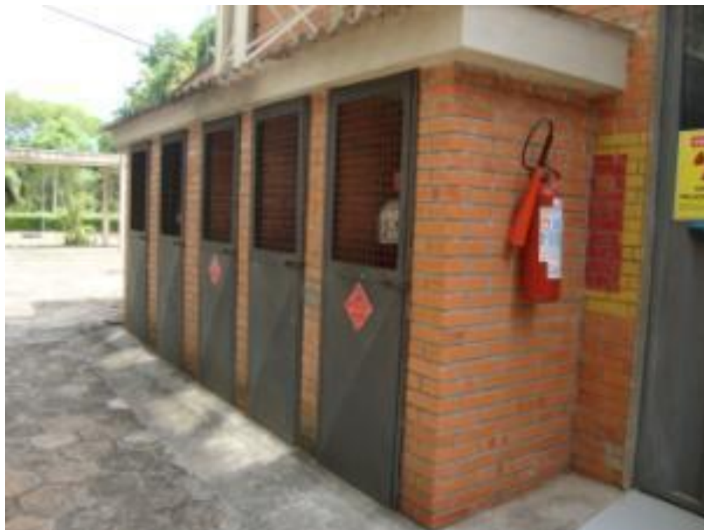
Fotografia nº 01 - Casa de gases para atender a dois Laboratórios da organização “A”
